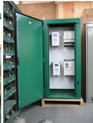
b) Tablero de control en construcción
